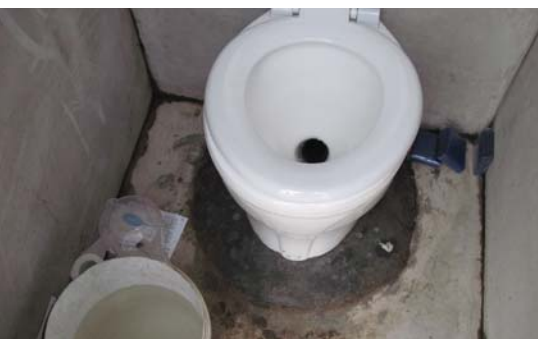
A fully constructed pour flush toilet
